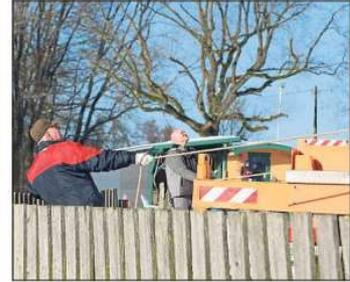
Mittels Seilen halten zwei Fachleute einen Mühlenflügel von unten fest, während die Kollegen vom Hubwagen aus in der Höhe montieren.
