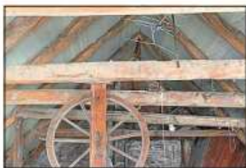
Ein Blick in den Dachstuhl der ehemaligen Apotheke.
