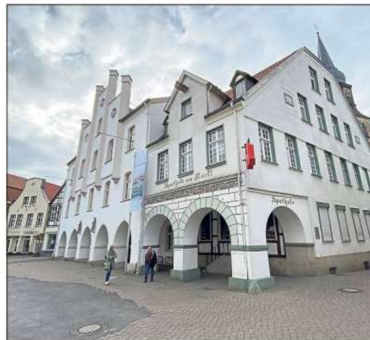
Die Bausubstanz des historischen Gebäudes Markt 2 ist schlechter als erwartet. Foto: Clauser
