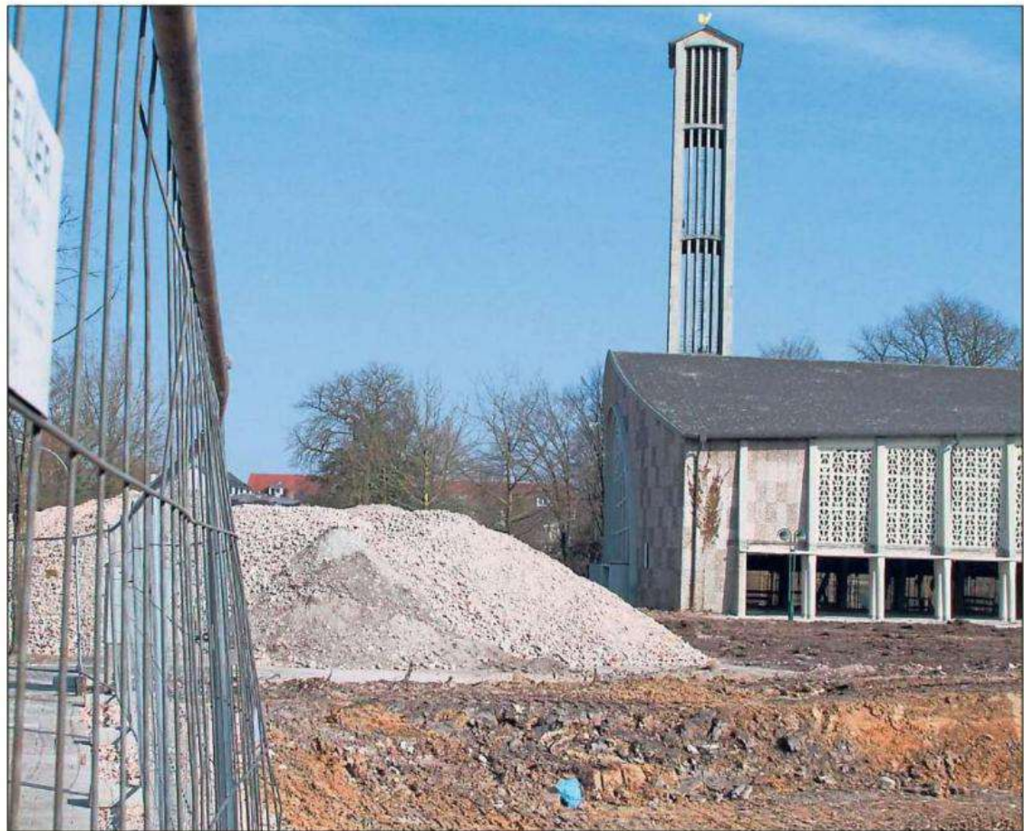
Auf der Baustelle an der profanierten Martinskirche laufen die Arbeiten. Auf dem Grundstück sollen sechs Mehrfamilienhäuser entstehen, die jetzt auch mit Balkonen ausgestattet werden. Bild: Krogmeier
