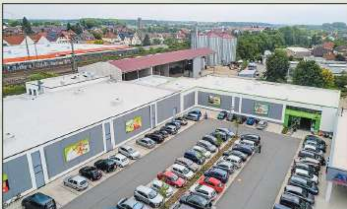
Der Raiffeisen-Standort in Oelde mit Markt und Mehrzweckhalle, Getreideanlage sowie ein Dünger- und Pflanzenschutzlager.
