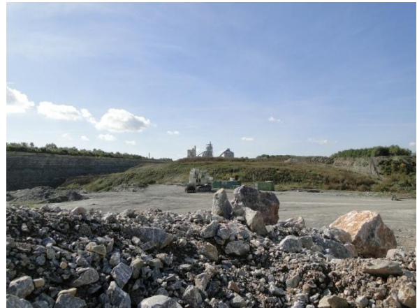
Blick in den Steinbruch der Firma Phoenix Zementwerke in Beckum.
