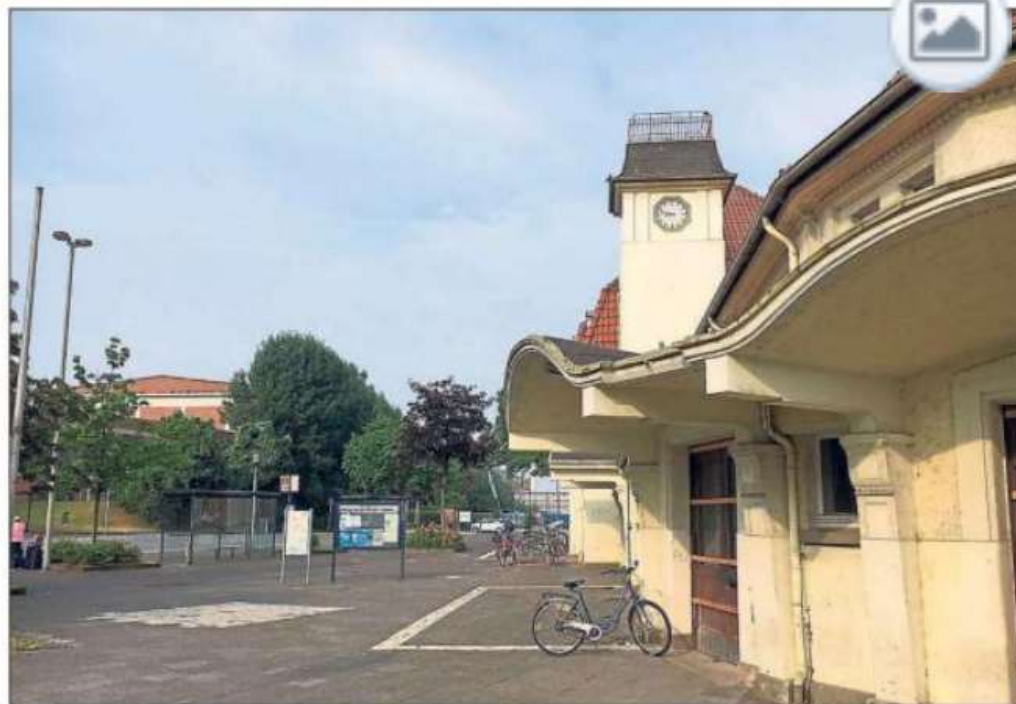
Von Baugeräten und -materialien ist der Neubeckumer Bahnhofsvorplatz inzwischen befreit. Jetzt soll er regelmäßig und häufiger als zuvor gereinigt werden. Bilder: Clauser
