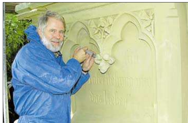
Steinmetz- und Bildhauermeister Ludger Wennemer schließt kleine Risse und bringt Steinfestiger mit der Injektionsspritze in den Stein.
