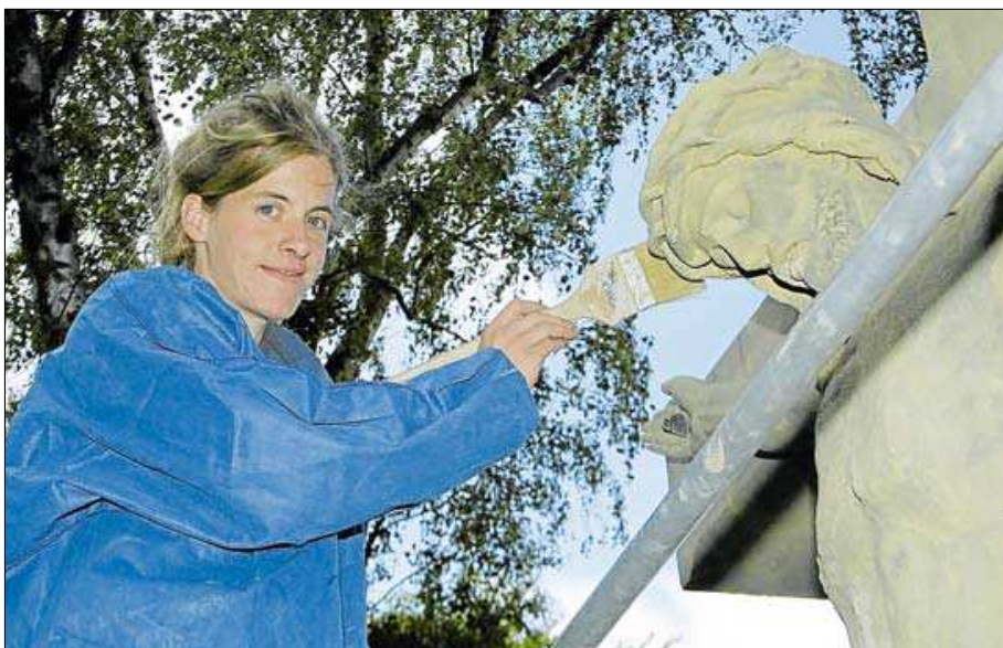
Mit dem Auftragen einer Lasur wird der Sandstein geschützt. Lara Frielinghaus arbeitet am Hochkreuz auf dem Friedhof an der Elisabethstraße in Beckum. Bilder: Krogmeier
